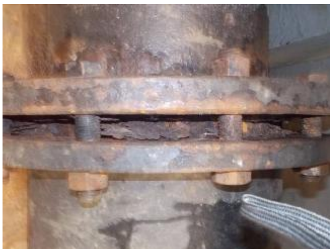
Poškození potrubí ve středním, resp. pravém sektoru
